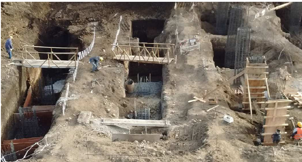
Fig. 56. Foto de obra donde se aprecia la magnitud de las excavaciones para ejecutar las bases.
