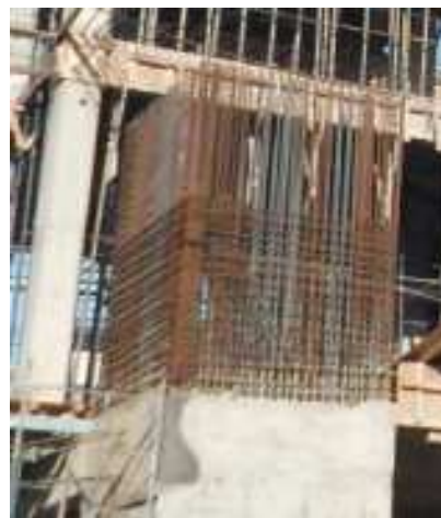
Fig. 54. Fotos tomadas en obra y planos del tabique donde se aprecia la gran de armadura colocada.
