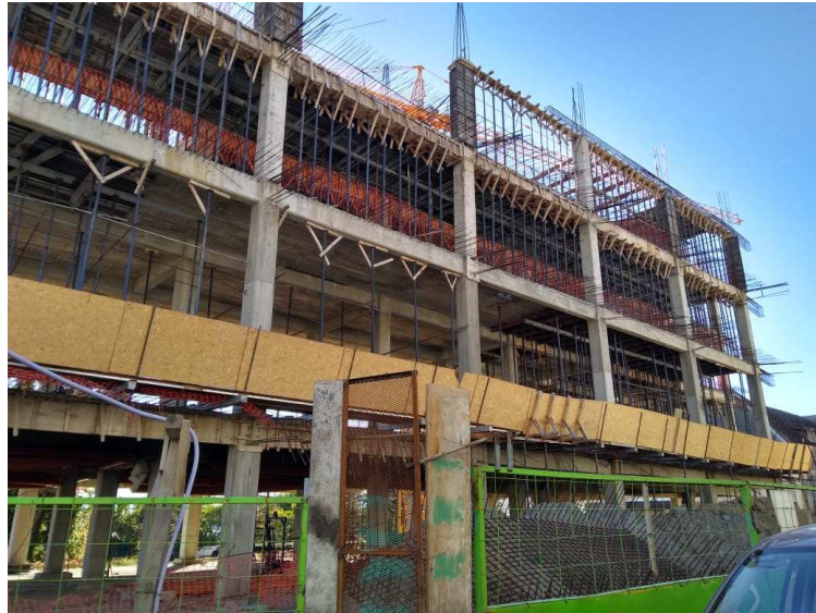
Fig. 3(a). Avance de construcción en el EP.
